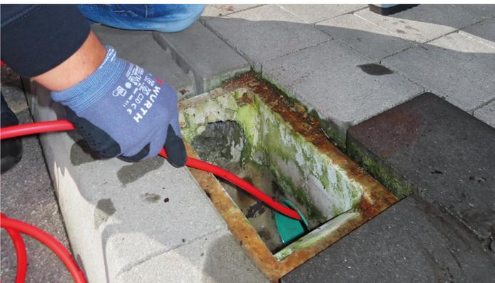
Rohreinigungsschlauch mit Sprühstrahl und Vortrieb 15 m
